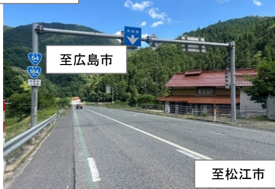
施工箇所付近
