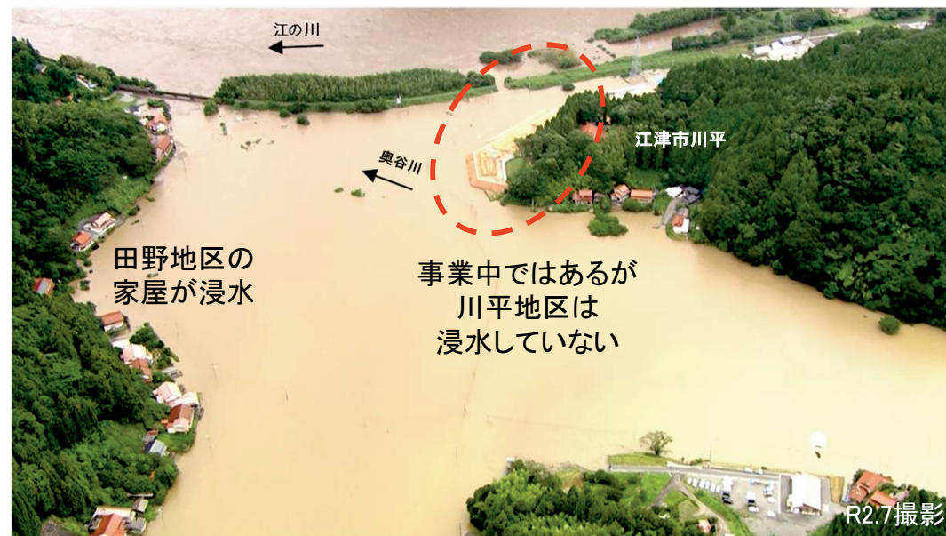
令和2年7月豪雨時
