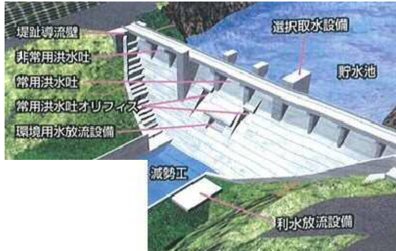
図 9-2 ダムの放流設備
