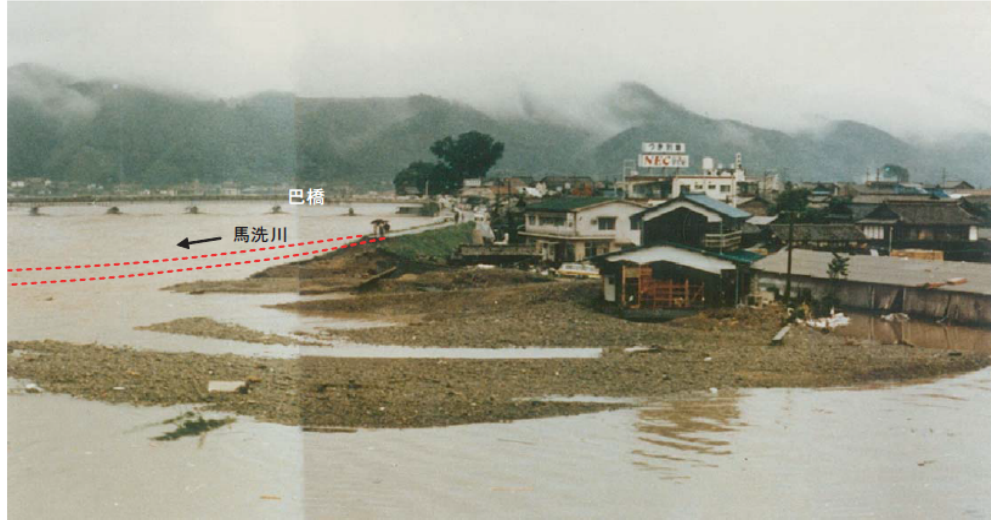
三次市十日市地区 馬洗川の破壊箇所
