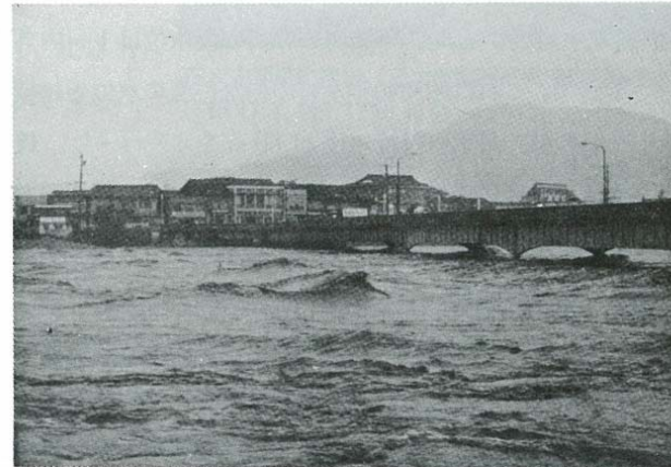
激流橋脚を嘔む巴橋，対岸は三次住吉町 (7月11日午前11時半頃)
