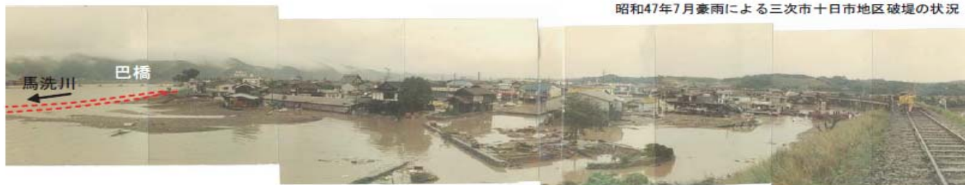
昭和47年7月豪雨による三次市十日市地区破堤の状況
