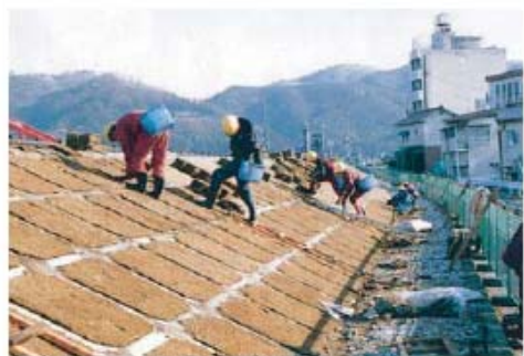
川裏法面への張芝施工状況
