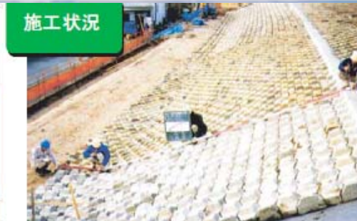
施工状況 ふとんかごの境内への埋め込み準備
