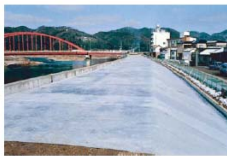
堤防天端への遮水シート施工状況
