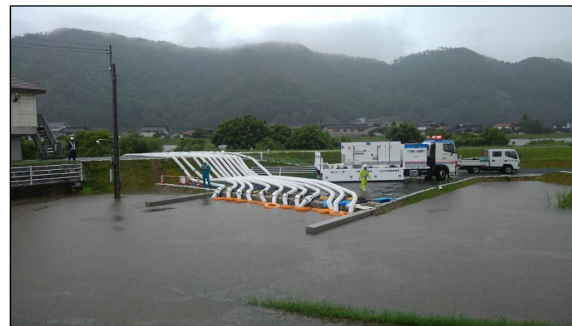
排水ポンプ車の排水状況(7月5日:常友岩の城排水樋門)
