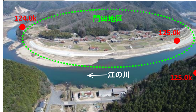
堤防整備状況
