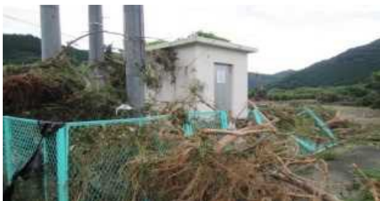
他ダムにおける放流警報設備の浸水後の状況 ～「異常豪雨の頻発化に備えたダムの洪水調節機能に関する検討会」の提言～より
