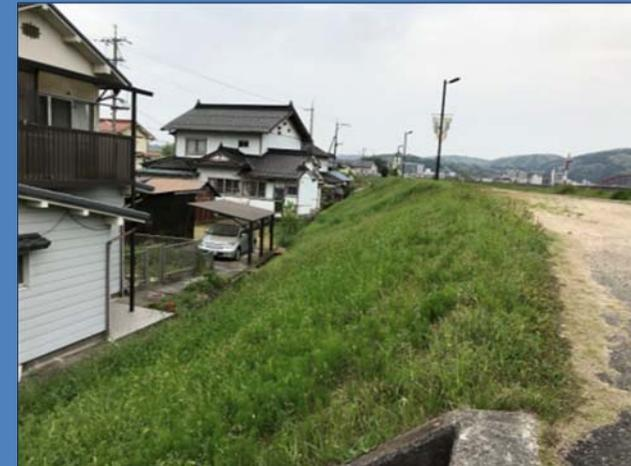
堤防裏法尻補強必要箇所のイメージ
