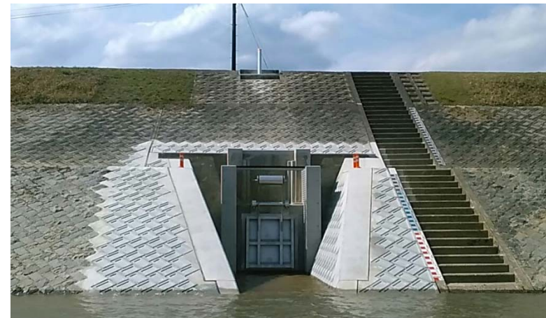
※写真は、令和元年度に無動力化を実施した下甲立排水樋門(江の川左岸156.1k付近)
