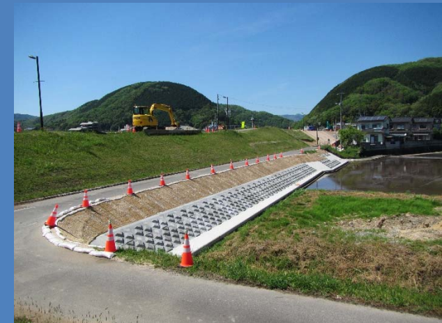
西城川 左岸 寺戸地区 施工状況
