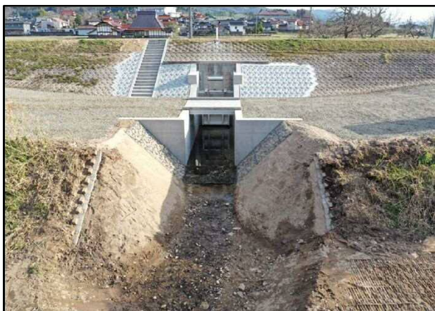
【下川立2号排水樋門】 (江の川 右岸152k400付近)
