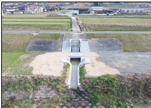
【下川立1号排水樋門】 (江の川 右岸152k000付近)
