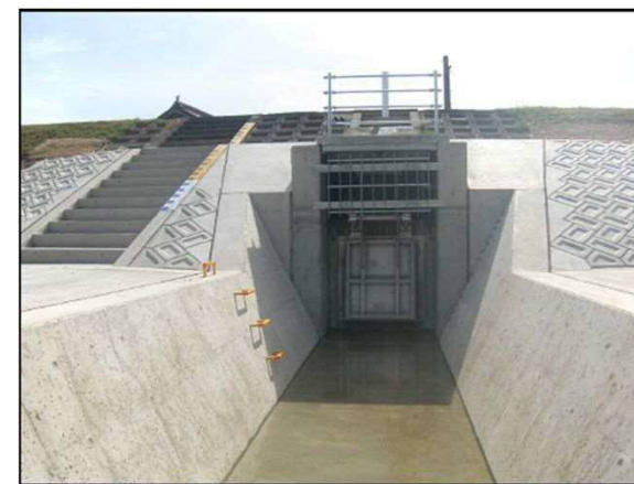
【下小原1号排水樋門】 (江の川 右岸 162k700付近)
