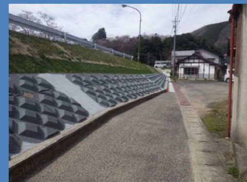
三次地区 施工状況
