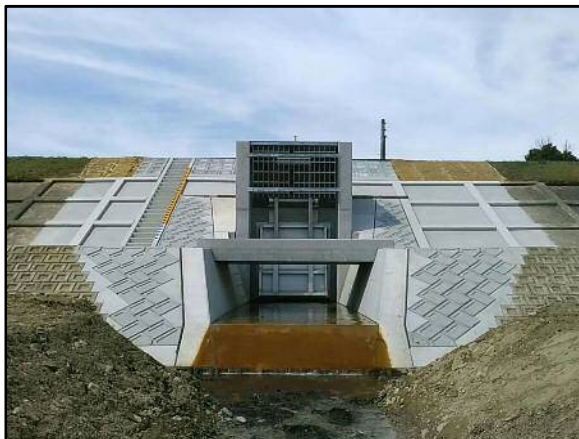
【深瀬2号排水樋門】 (江の川 左岸 153k400付近)
