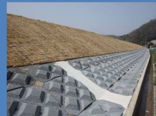
中所地区 施工状況
