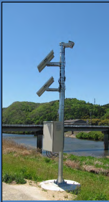
簡易型河川監視 カメラ
