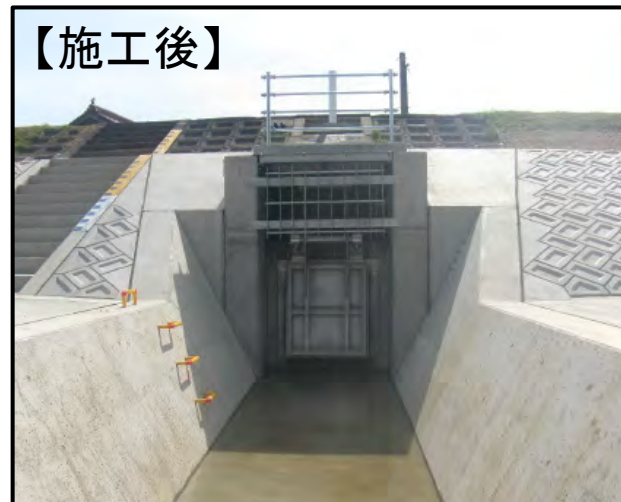
【下小原1号排水樋門】(江の川 右岸 162k700付近)
