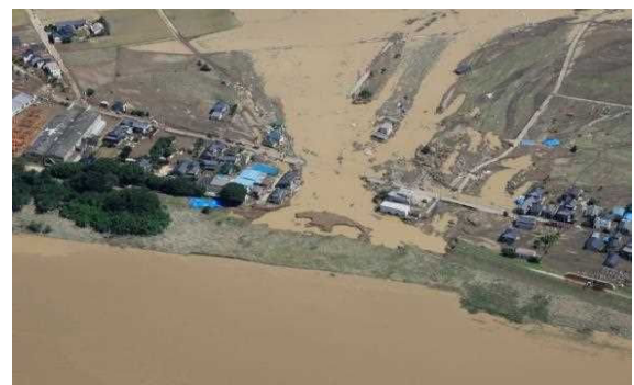
堤防決壊による家屋の流失(鬼怒川)
