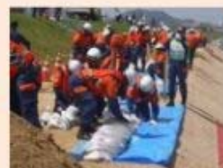
改良積土のう工法
