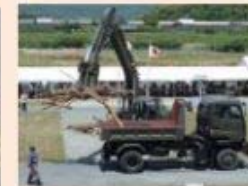
流木撤去訓練
