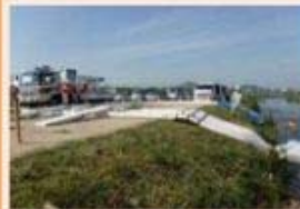
TEC-FORCEによる緊急排水活動訓練
