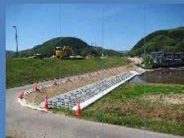
西城川 左岸 寺戸地区 施工状況
