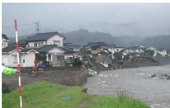
河岸侵食による家屋の倒壊(花月川)
