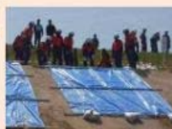
シート張り工
