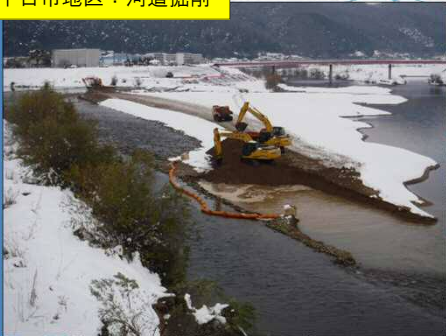
十日市地区：河道掘削
