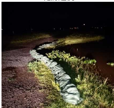
岩木川左岸（野木地先） 積み土のう工
