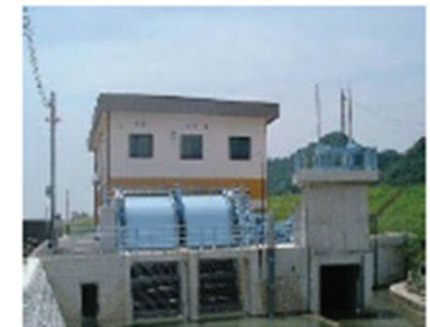
排水機場の整備
