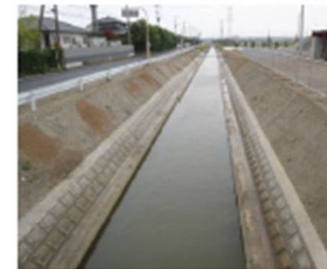
排水路の整備
