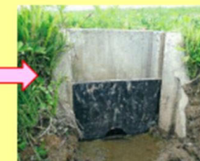
水戸板設置状況
