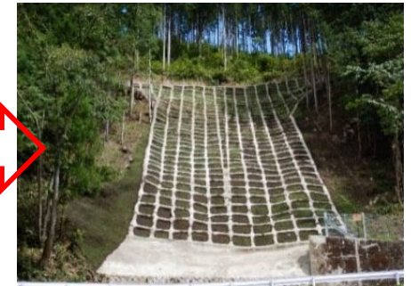
山腹工（施工後）
