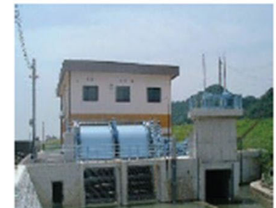
排水機場の整備
