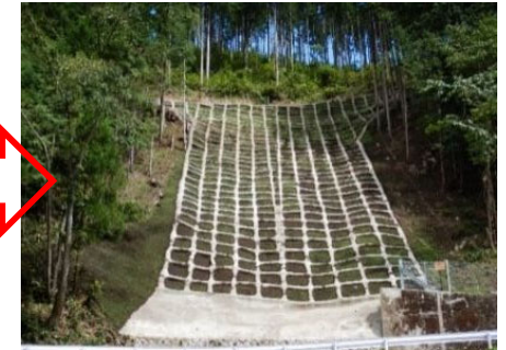
山腹工（施工後）
