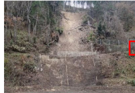
山腹崩壊（施工前）
