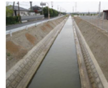
排水路の整備
