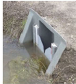
堰板等を設置し、雨水を水田に一時的に貯留
