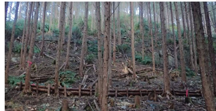
保安林整備（本数調整伐＋丸太筋工）
