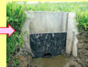
水戸板設置状況
