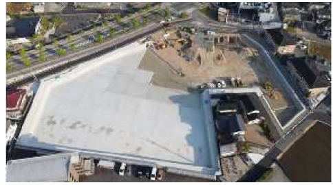
雨水貯留施設（三次市願万地地区）
