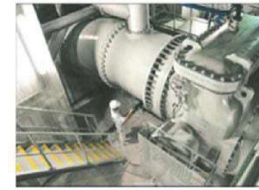
雨水ポンプの整備
