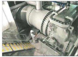
雨水ポンプの整備
