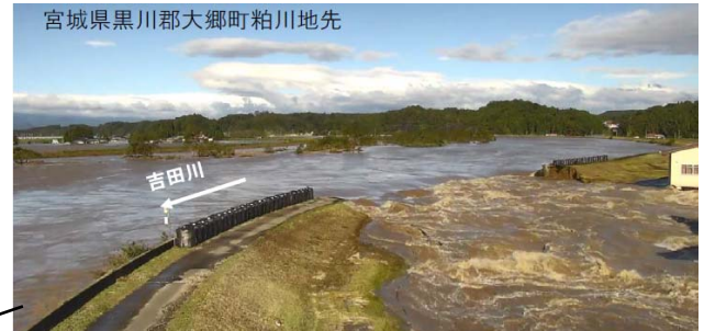
【吉田川左岸20.9k 堤防決壊箇所】
