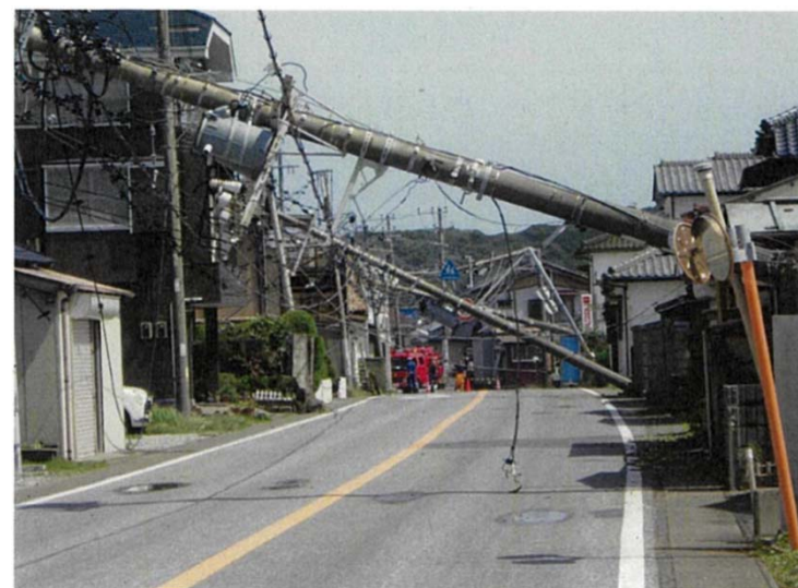
電柱倒壊 館山市船形
