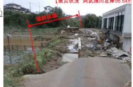
阿武隈川上流 決壊状況 浜尾第2樋門(98.6k付近) 福島県須賀川市浜尾地先
