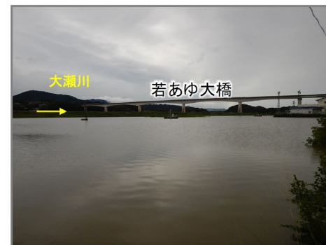
五ヶ瀬川右岸9k000付近 内水被害状況（9月19日09:00頃）
