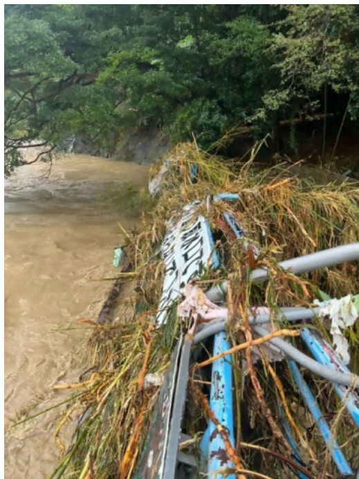
承元寺取水口の様子（興津川）
