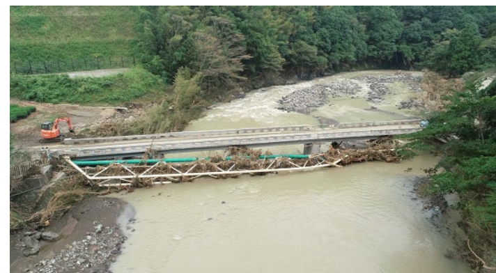
水管橋の損壊（興津川・宮嶋橋）
