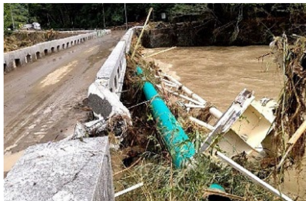
水管橋の損壊（興津川・宮嶋橋）
