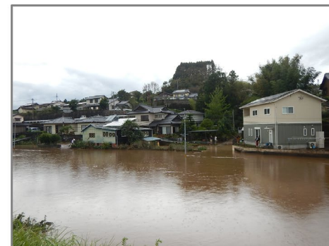
五ヶ瀬川左岸9k400付近堤内側を望む（9月19日09:00頃）
