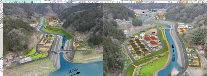
37 ① 矢谷川下流から上流を望む
