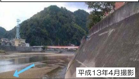
大竹地区（本町箇所）整備前の状況
