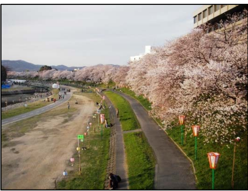
「旭川さくらみち」護岸整備前
