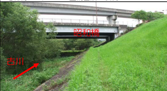
昭和橋アンダーパス整備箇所の状況
