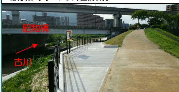
昭和橋アンダーパスの整備状況
