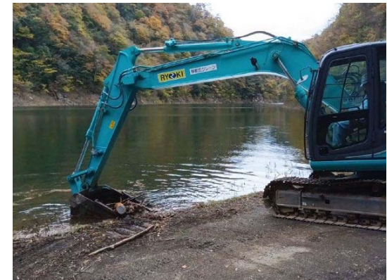
流木の回収状況
