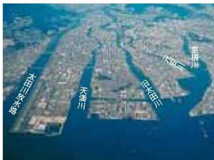
③市内派川 (太田川放水路 昭和42年完成)
