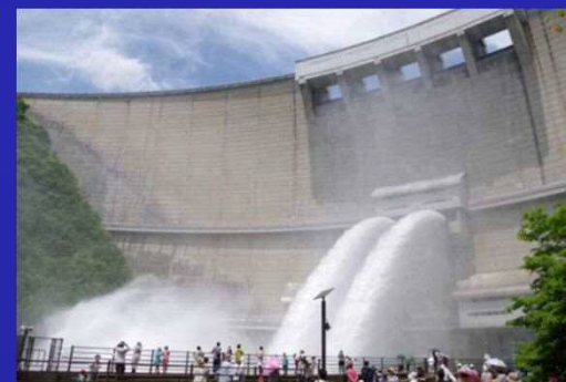
例年の中位標高放流設備からの放流状況
