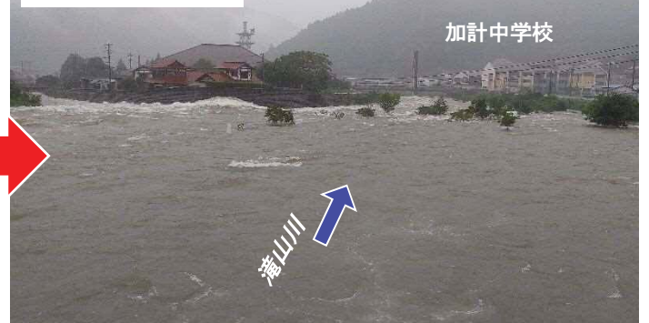
今回の洪水時の加計中学校付近（滝山観測所水位約3.31m）
