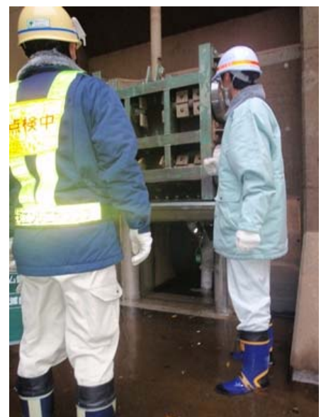
樋門ゲート点検
