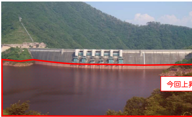
普段のダム貯水位（標高350.30m）
