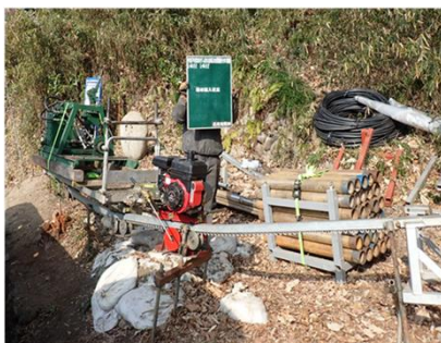
モノレール設置状況 (資機材運搬のためモノレールを設置する場合があります。)
