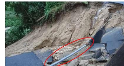
道路崩壊による管路露出(真備町市場地区)
