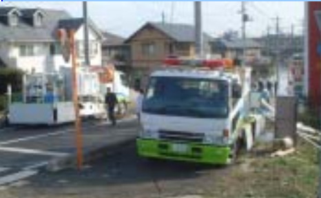
排水ポンプ車(0.5m 3 /s) の稼働状況
