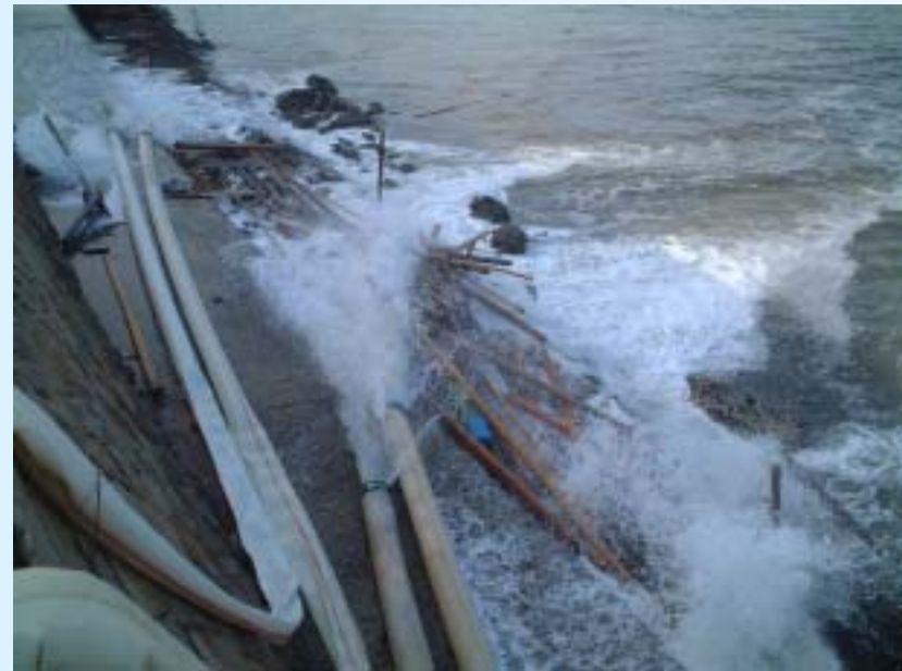
排水ポンプ車(0.5m 3 /s)と海への排水状況
