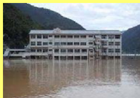
H26.8避難所2階の浸水 (徳島県)
