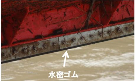
(※) 水密ゴムとは、ゲートの水漏れを抑制する
