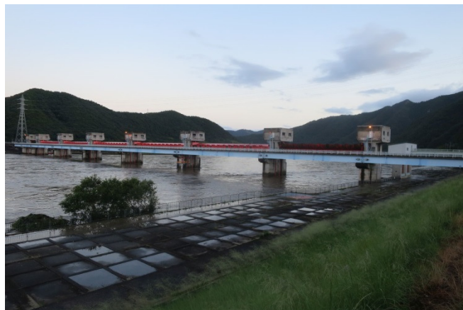
全開状況（管理橋高さ付近まであげています）
