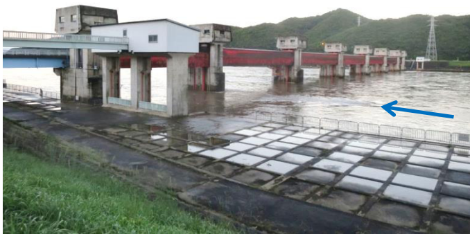
ゲート全開状況(9/18 左岸上流側から撮影)
