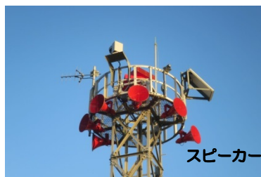
放流警報所の位置(右図)とスピーカー設置例(上写真)(手前側が川方向です)
