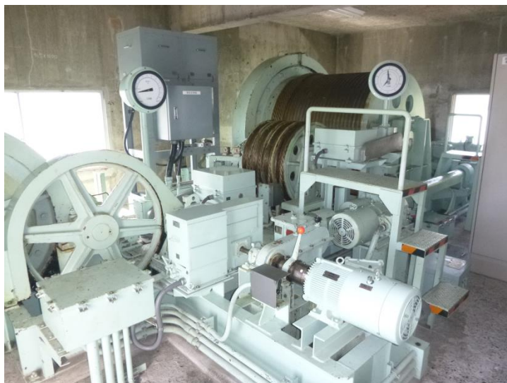
堰の中の機械室
