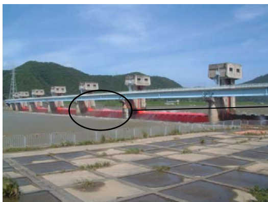
強風にあおられ、溜めた水が堰を越える状況(9月16日10時00分時点)
