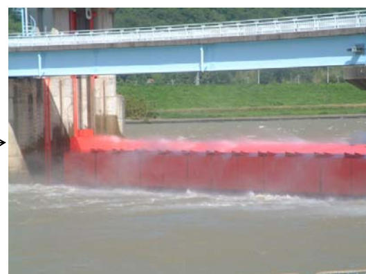
強風にあおられ、溜めた水が堰を越える状況(9月16日10時00分時点)
