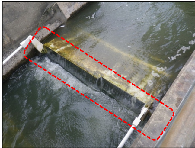
可動隔壁により剥離流が発生
