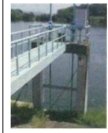
樋ノ口取水口
