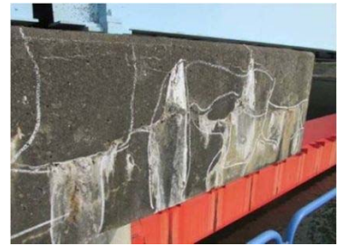
【管理橋の漏水・遊離石灰 H25】
