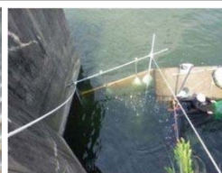
パネルの設置 ⇒魚道入口へ誘導
