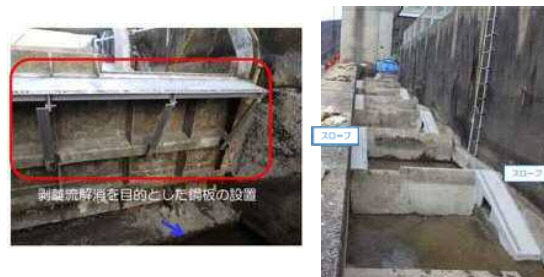
【左岸魚道の漁協ヒアリング状況】
