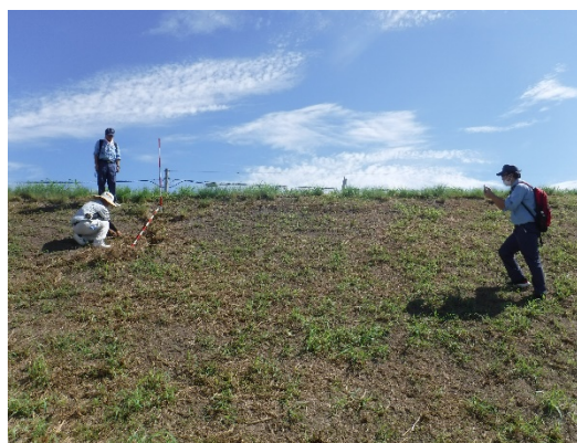
堤防点検の実施状況
