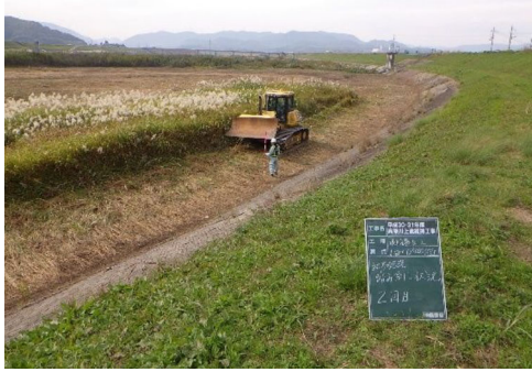
ブルドーザによる踏み倒し状況
