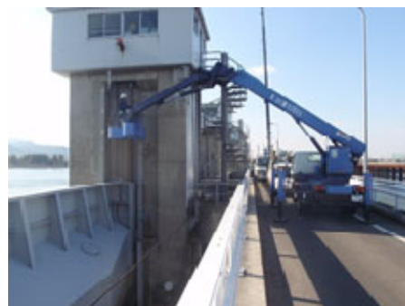
百間川河口水門の点検状況
