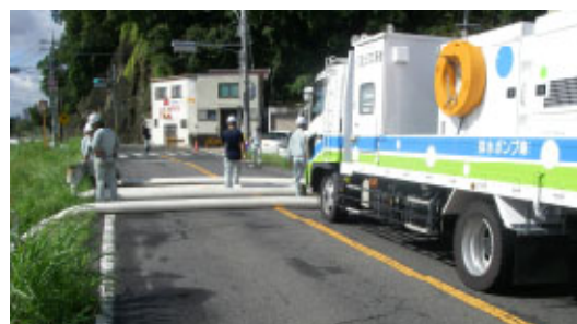
排水ポンプ車出動状況 (平成23年9月台風12号)
