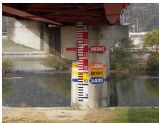
水位表示板（中原橋）
