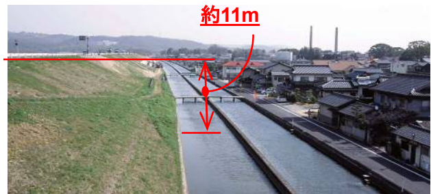
酒津地区の堤防の状況
