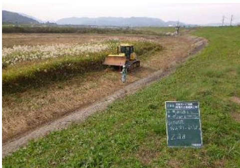
ブルドーザによる踏み倒し状況
