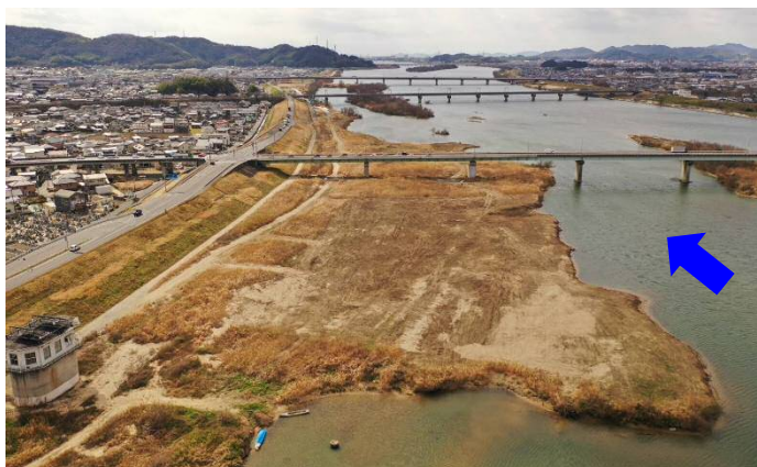
整備後の現状 (西阿知箇所、令和2年)
