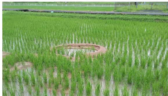
漏水に伴う噴砂の発生状況 (平成 30 年 7 月洪水、吉井川右岸 14.4k 付近)
