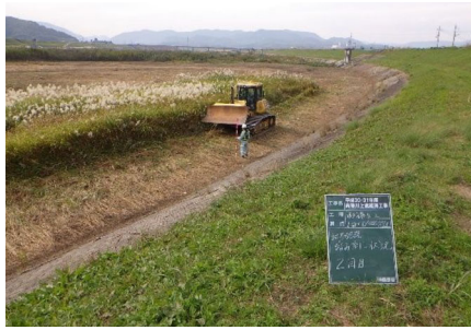
ブルドーザによる踏み倒し状況
