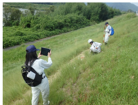
堤防点検の実施状況
