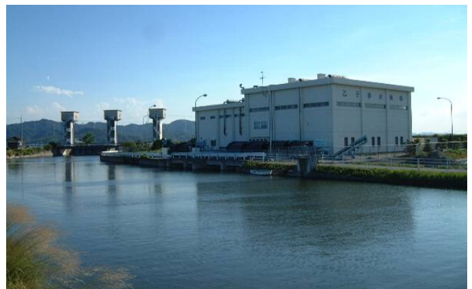
乙子排水機場（千町西川）
