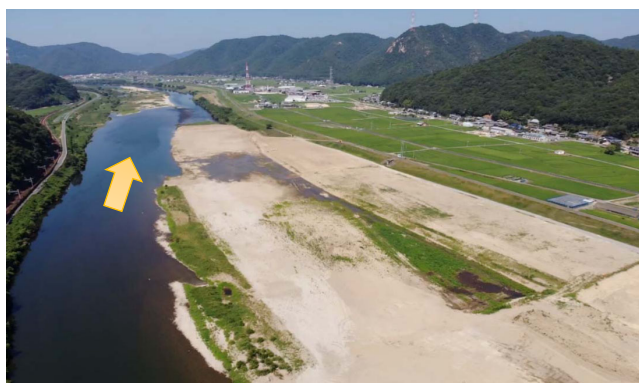
整備後の現状（田原箇所、令和2年）
