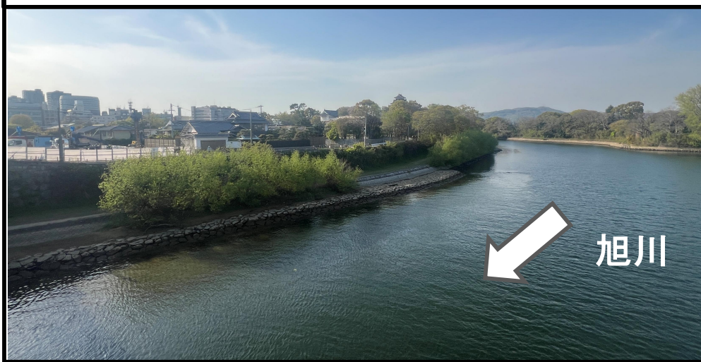
施工前 令和7年4月
