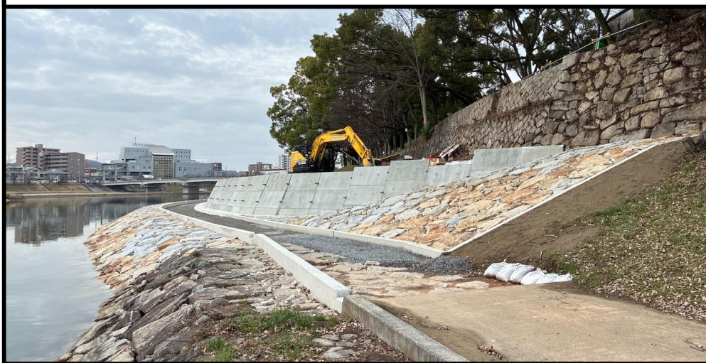
施工状況 令和8年2月
