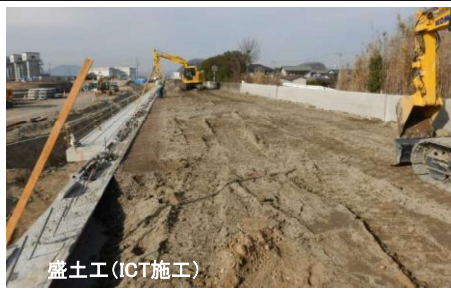
施工状況 令和6年2月
