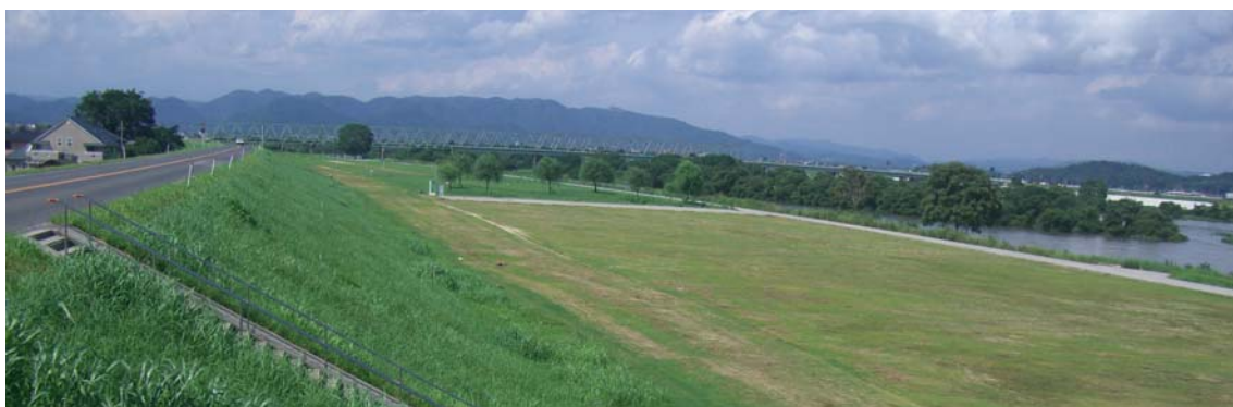
開放的な河川空間
