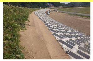
堤防法面の施工を完了し、高水敷の整地復旧を行っています
