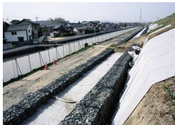
堤防補強におけるドレーン部の施工状況 (高梁川10.2k東岸側、倉敷市酒津地区)
