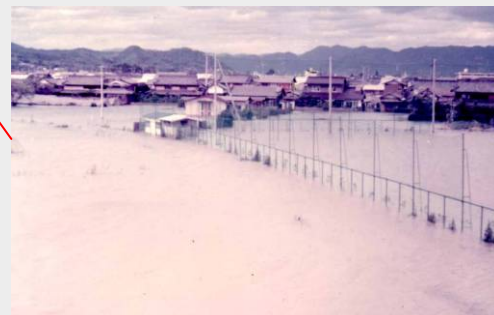
内水による浸水状況(倉敷市真備町川辺)
