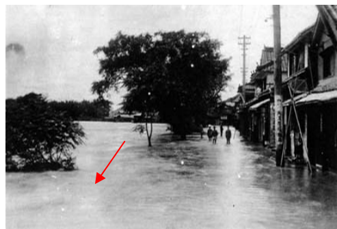
矢掛町川面地区 小田川の氾濫状況
