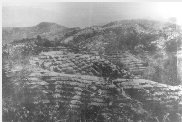
井風呂谷川流域の砂防工事の状況(明治42年11月)
