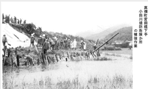
宮田橋下流の堤防補強作業(倉敷市真備町) [岡山県, 昭和51年9月台風17号災害誌]
