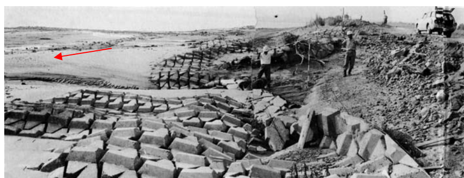
倉敷市鶴新田 低水護岸被災状況
