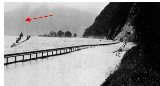
総社市栗付付近 国道180号の浸水状況
