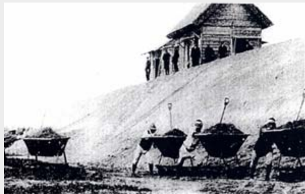
さかつ 酒津付近の築堤工事(明治44年)
