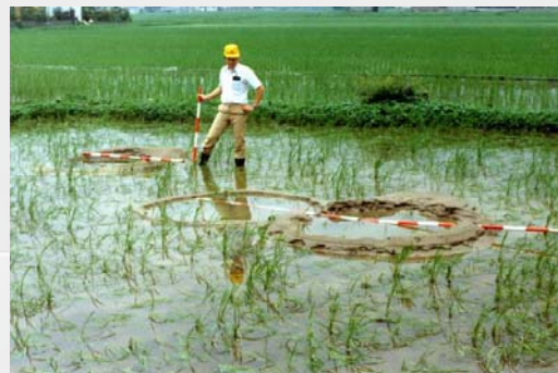
基盤漏水によるガマの発生状況 (昭和60年6月洪水・倉敷市真備地区)
