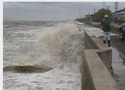
高梁川の高潮越波状況 (平成16年台風16号・倉敷市玉島乙島地区)
