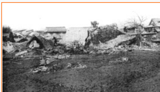
倉敷市真備町川辺字辻尾 家屋倒壊状況
