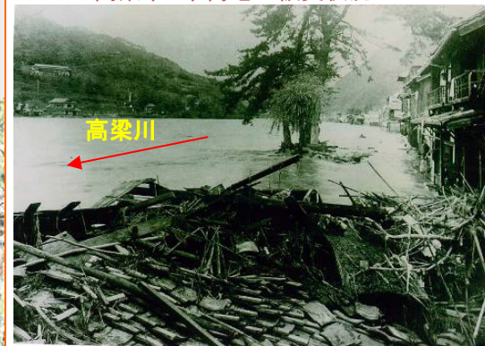
高梁市 高梁川左岸の氾濫状況
