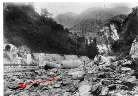
JR伯備線井倉駅付近 高梁川鉄橋流失状況
