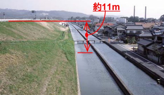
第一期改修で築造された高い堤防(高梁川9.8K東岸側・倉敷市酒津)
