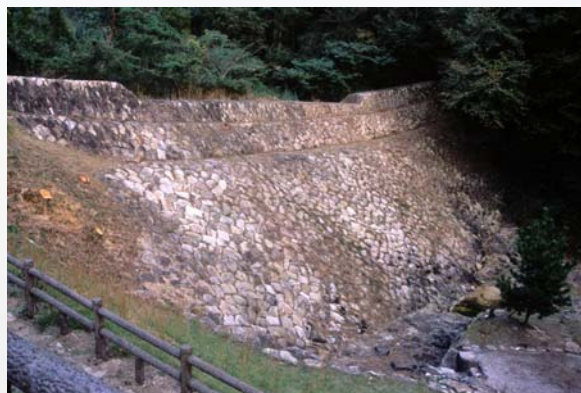
井風呂谷川3号(砂防)堰堤 (M33頃完成・後年嵩上げ・国登録有形文化財・土木学会日本の近代土木遺産)
