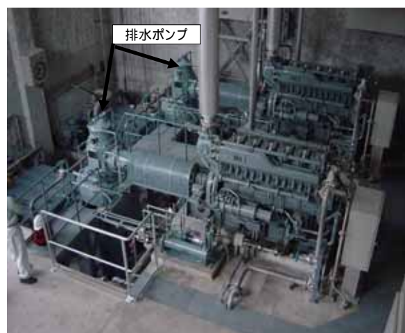
【排水ポンプ設備:排水量 1.5\text{ m}^3/\text{s} \times 2 台】 (毎分 90\text{ m}^3 )
