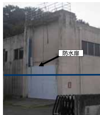
【開扉状況(通常時は上に吊り上げている)】【閉扉完了状況(外観)】
