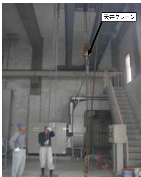
【屋内の天井クレーンを使用し閉扉操作を行う】
