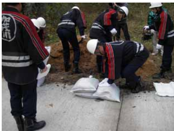
土のう設置訓練の様子
